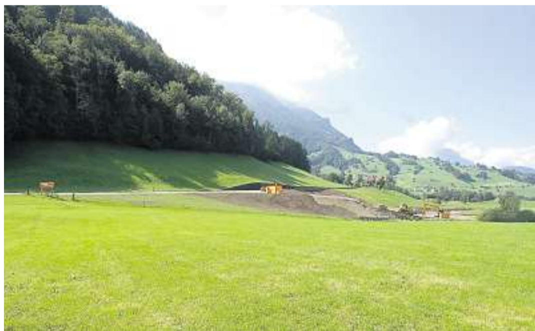
Soll doppelt so gross werden: Die Aushubdeponie an der Schwyzer Grundstrasse.
