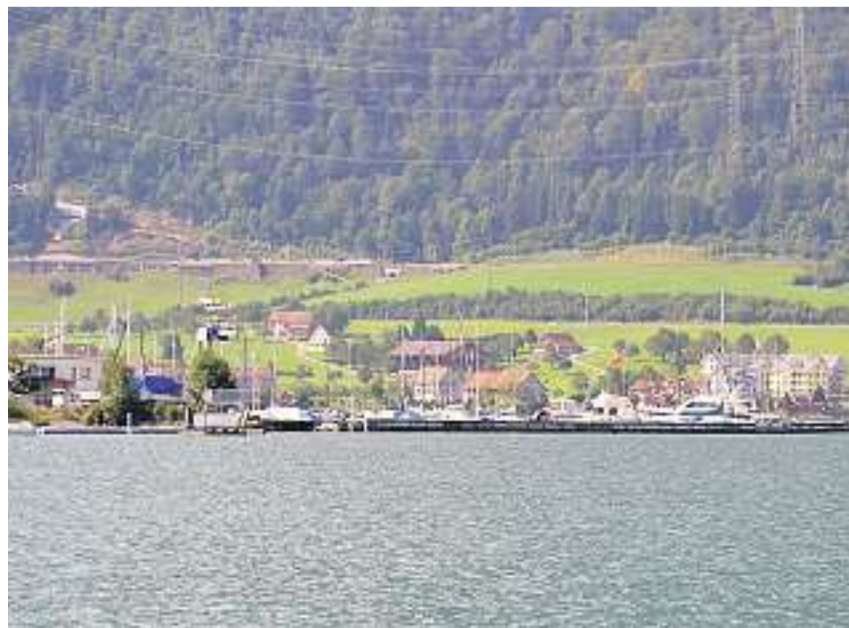
Die Hafentmole im Arther Aazopf: Bereits diesen Winter sollen hier die Ufermauern saniert werden. Bild Martin Schmid
